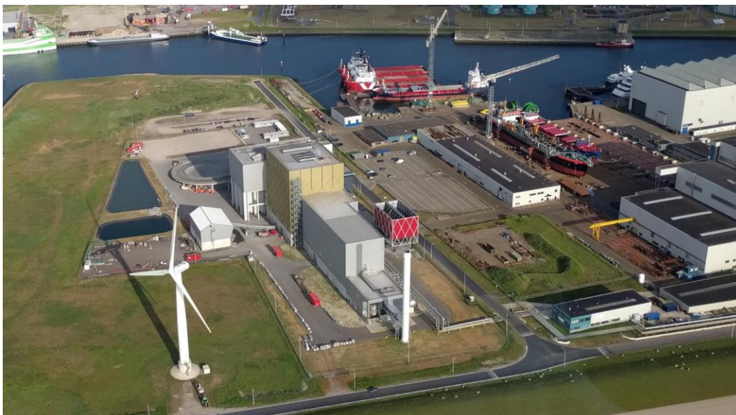
ReststoffenEnergieCentrale (REC) Harlingen
